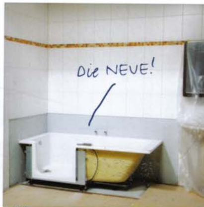
13.00 TWINLINE-WANNE EINPASSEN, ABFLUSS ANSCHLIEßEN.
