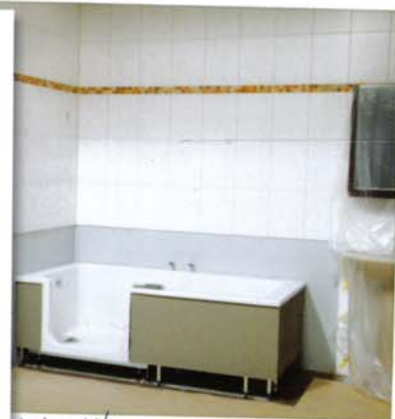
15:15 Uhr SCHÜRZE WIRD MONTIERT.
