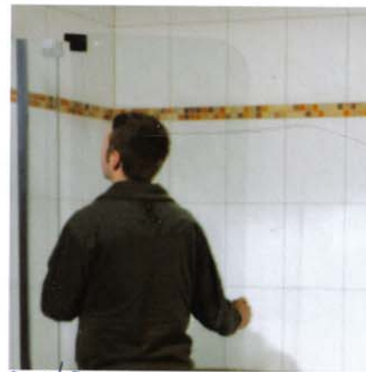
8 UHR FLIESEN VERFUGEN + TWINLINE- -TÜR MONTIEREN
