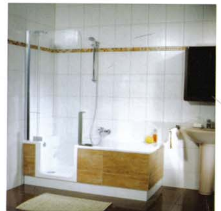
10 UHR: DUSCH-ARMATUREN MONTIEREN: DIE NEUE TWINLINE2 IST FERTIG!
